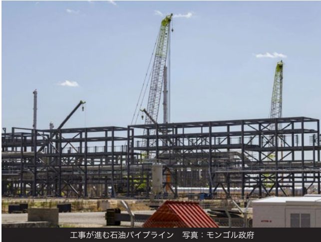
工事が進む石油パイプライン 写真：モンゴル政府
